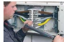
Клеммы должны быть затянуты с определенным усилием
