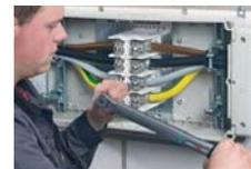
Клеммы должны быть затянуты с определенным усилием
