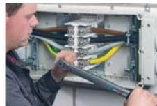
Клеммы должны быть затянуты с определенным усилием
