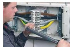
Клеммы должны быть затянуты с определенным усилием
