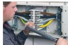
Клеммы должны быть затянуты с определенным усилием
